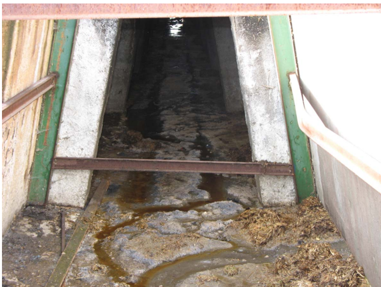
Foto 4.17. Riknenud silomahl ja -jäägid hoidla vahetus ümbruses (autor: A. Olt)
