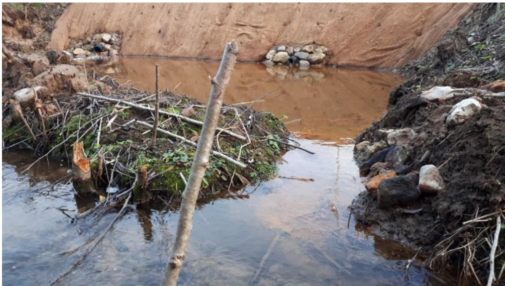
Joonis 2.38. Keeni suudmelodu rekonstrueerimine (eesvoolu ja suudmelodu veetasemed suudmetega samal kõrgusel).
