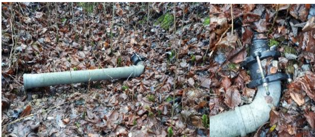
Joonis 2.46. Paisutustoru ja selle kinnitus Pärna 1 ja Pendre ehitistel.
