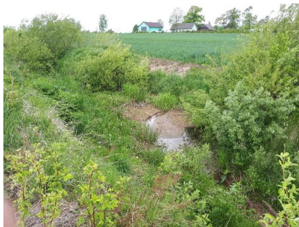
Joonis 2.15. Põlva maakond, Habemiku talu Ibaste ehitise täis settinud puhastuslodu.
