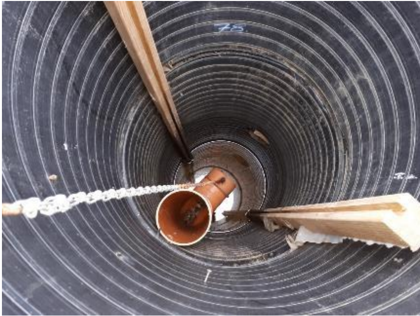
Joonis 2.47. Rekonstrueeritud seadedreanaazi kaev Lemme ehitisel.
