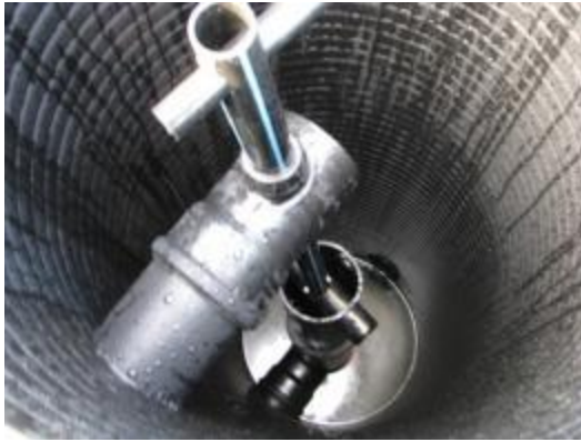
Joonis 2.43. Lemme ehitisele projekteeritud seadedreanaži regulaatorkaev
