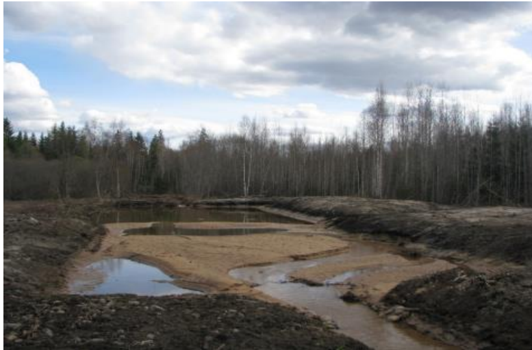
Joonis 2.16. Settebassein-puhastuslodu Lota ehitisel 2010 kevadel pärast suurvett.
