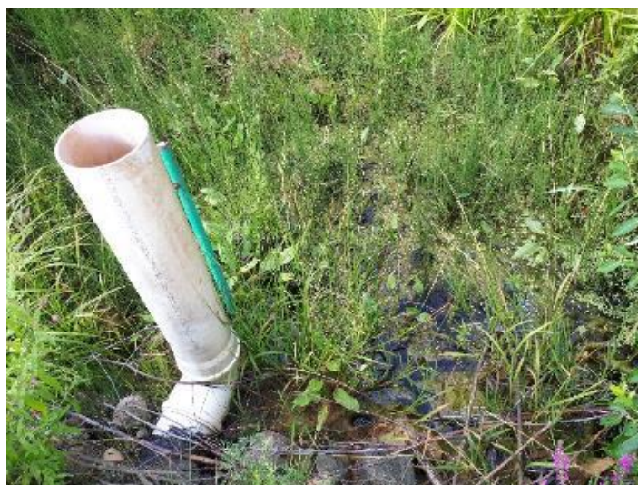
Joonis 2.45. Suudmes ülesse pööratav paisutustoru Lemme ehitisel.
