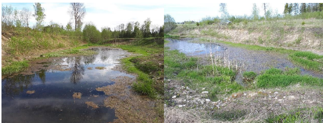
Joonis 2.25. Mäo MPÜ Huuksi ehitisel paiknev settebassein-puhastuslodu (vaade settebasseini ja lodu poolt).
