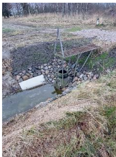
Joonis 2.50. Eesvoolu truubil olev regulaator
