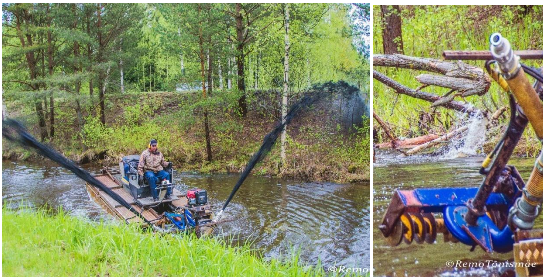
Joonis 2.10. Eesvoolu puhastamine pinnasepumbaga (foto R.Tõnismäe).
