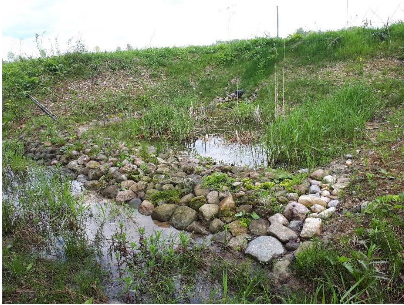
Joonis 2.39. Suudmelodu ehitisel Kokavälja II.
