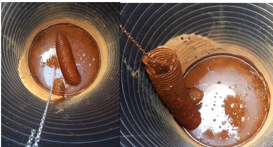
Joonis 2.52. Veetaseme reguleerimine kaevus tõstetava painduva toru abil Põlendmaa ehitisel Läänemaal (tellija Reena Rostin Oja –Andrese talu).
