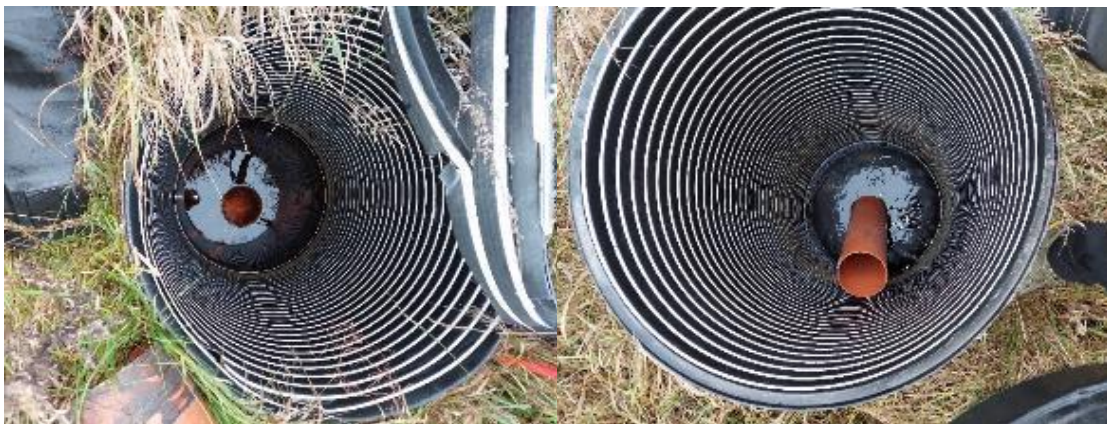
Joonis 2.49. Kaevregulaator Vesisoo ehitisel
