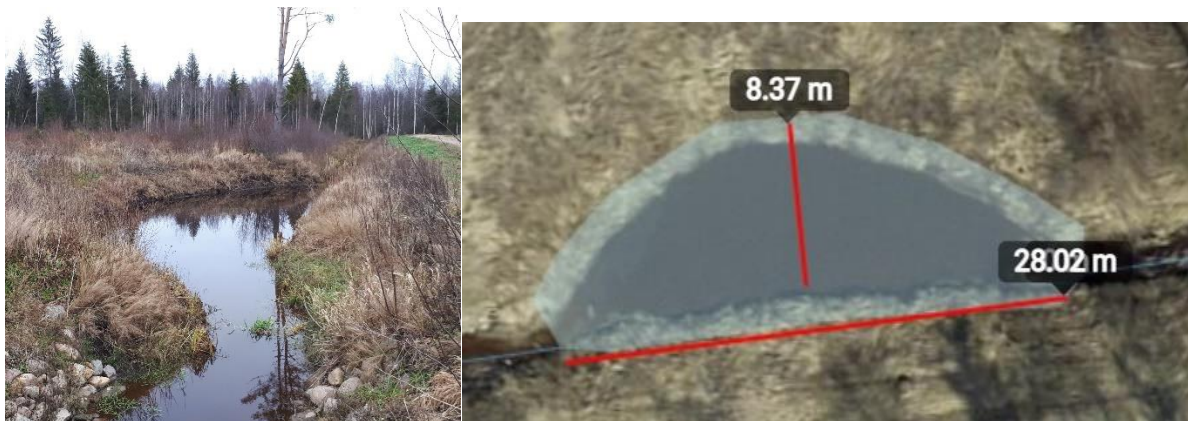
Joonis 2.2. Muhkva MPÜ Suure-Kõrtsi ehitisel segment-settebasein SB-1, R=18 m.
