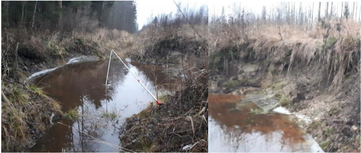
Joonis 2.6. Settebasseini nõlva voolamine saviliivpinnases (Võtikvere).
