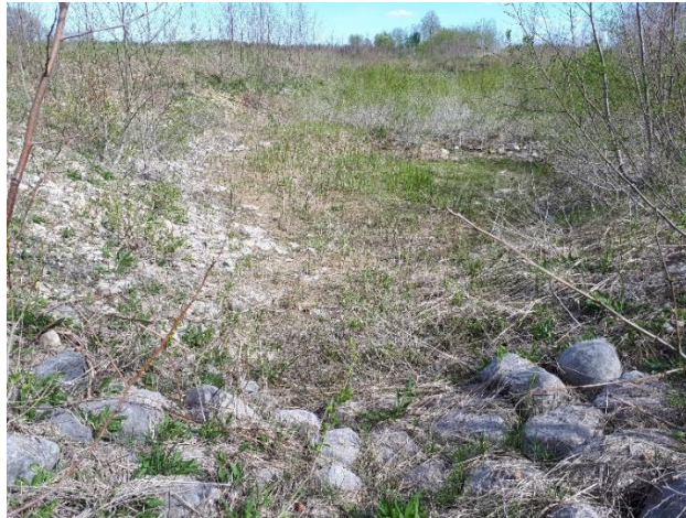
Joonis 2.14. Settebassein-puhastuslodu Pikaküla_Eivere ehitisel (Järvamaa). Vaade settebasseinile ja lodule.
