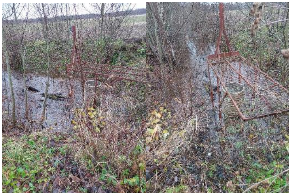
Joonis 2.51. Pärnumaa Tuudijõe maaparandusehitise seadedreanaaži regulaatorkaevud
