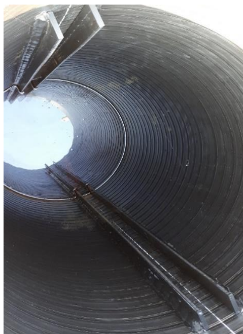
Joonis 1.5. Põlendmaa seadedreanaaži reguleerimiskaev.
